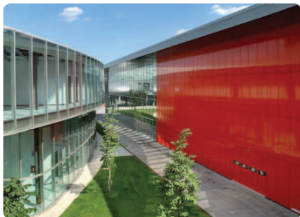
Nouveau Quartier de la foire de Milan - Milan, Italie / Architecte : Massimiliano Fuksas
