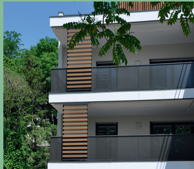
SPACE 6 - Teinte Sun • Architecte : Atelier Thierry Roche
